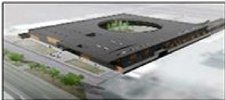
APERTURA. En marzo próximo abrirá el colegio, que está ubicado en la zona sur de Rancagua, cerca del nuevo hospital de la región.
